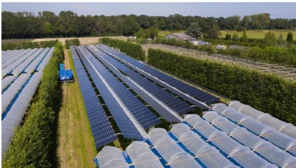
Himbeerfarm in den Niederlanden, 10 Grad nach Osten und Westen, Experimente mit Modulen läuft, Endausbau 3 MW
